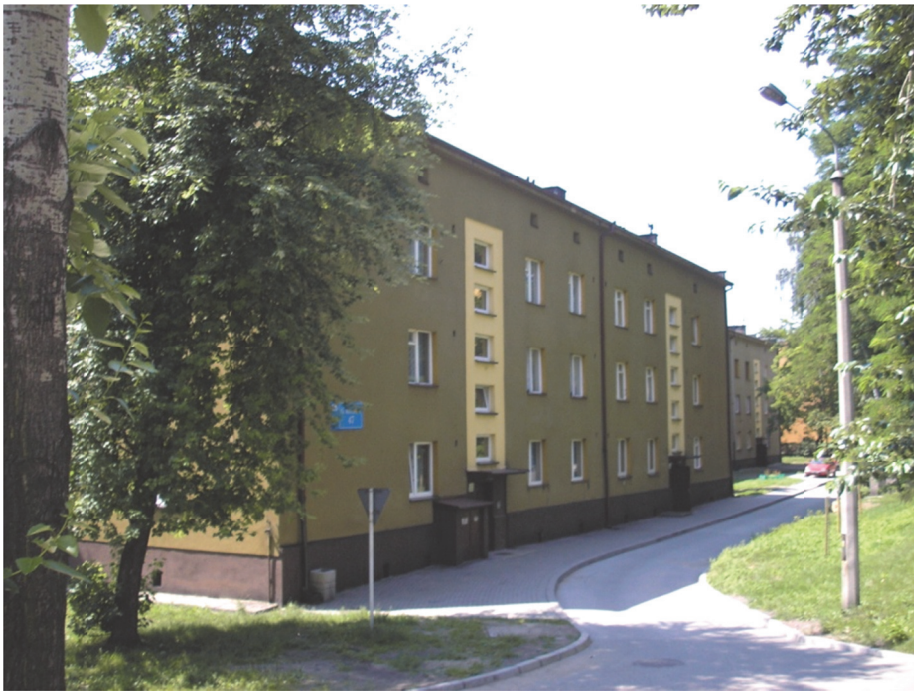
Fot. 6.4. Budynki mieszkalne trzykondygnacyjne wybudowane w technologii tradycyjnej
