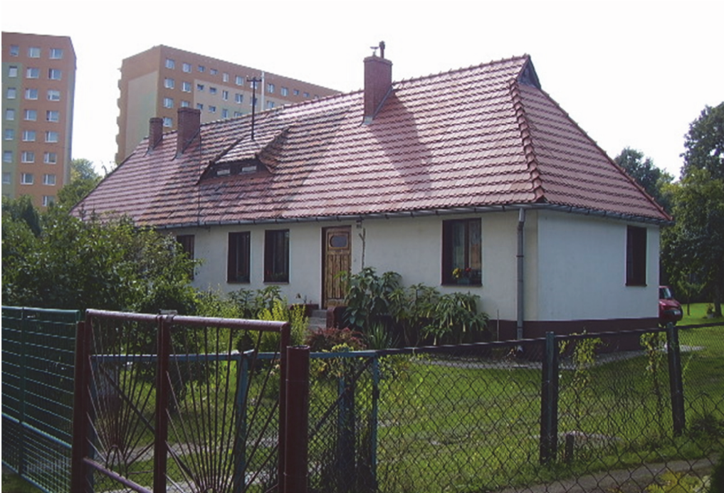
Fot. 6.11. Budynek mieszkalny jednorodzinny wybudowany w technologii tradycyjnej
