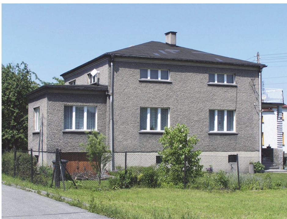
Fot. 6.8. Budynek mieszkalny jednorodzinny wybudowany w technologii tradycyjnej
