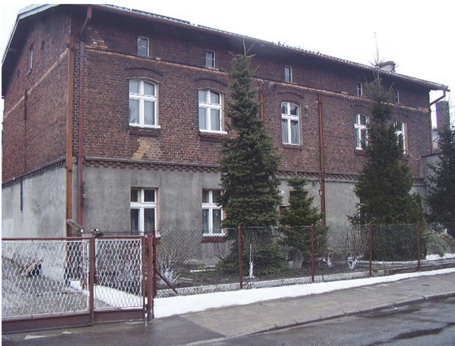
Fot. 6.13. Budynek mieszkalny wybudowany w technologii tradycyjnej
