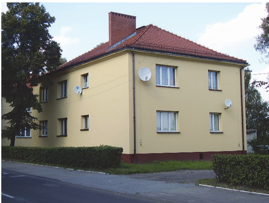
Fot. 6.5. Budynek mieszkalny dwukondygnacyjny wybudowany w technologii tradycyjnej
