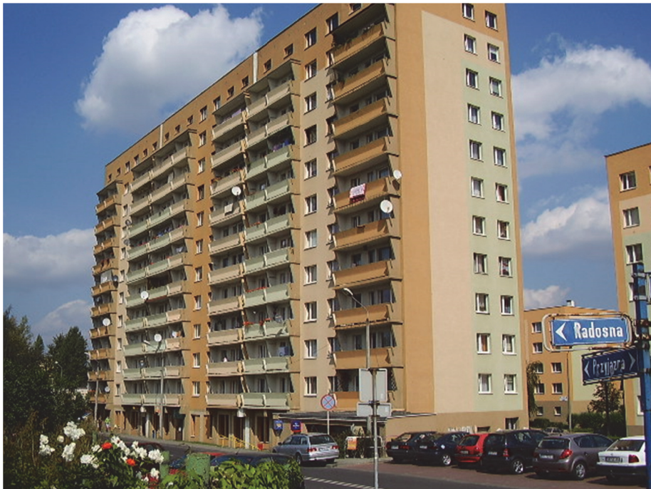
Fot. 6.1. Budynek mieszkalny jedenastokondygnacyjny wybudowany w technologii wielkopłytywowej
