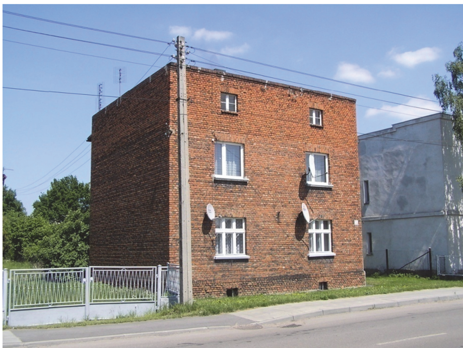
Fot. 6.9. Budynek mieszkalny jednorodzinny wybudowany w technologii tradycyjnej
