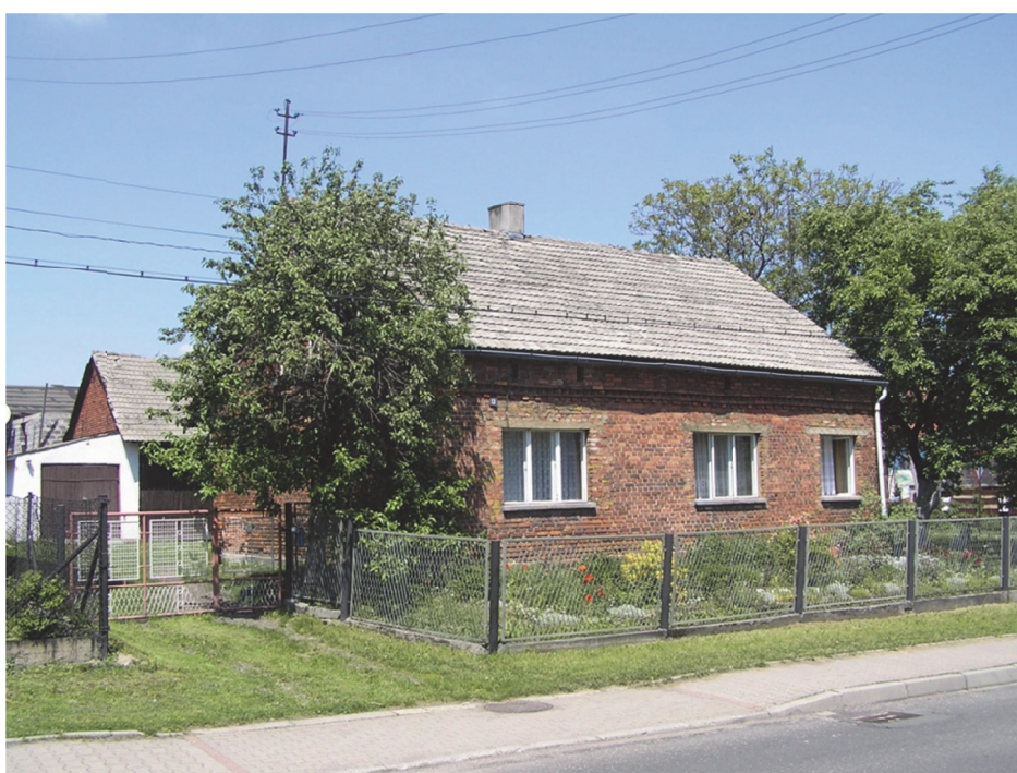
Fot. 6.10. Budynek mieszkalny jednorodzinny wybudowany w technologii tradycyjnej
