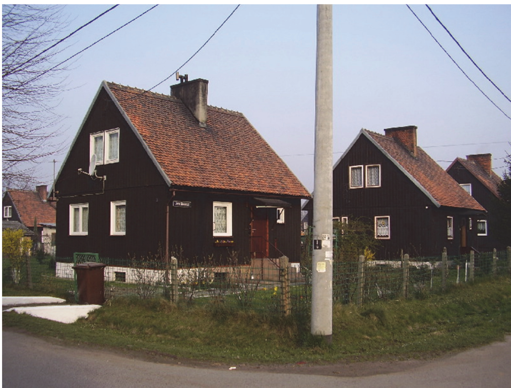
Fot. 6.20. Budynek mieszkalny drewniany wybudowany w technologii tradycyjnej
