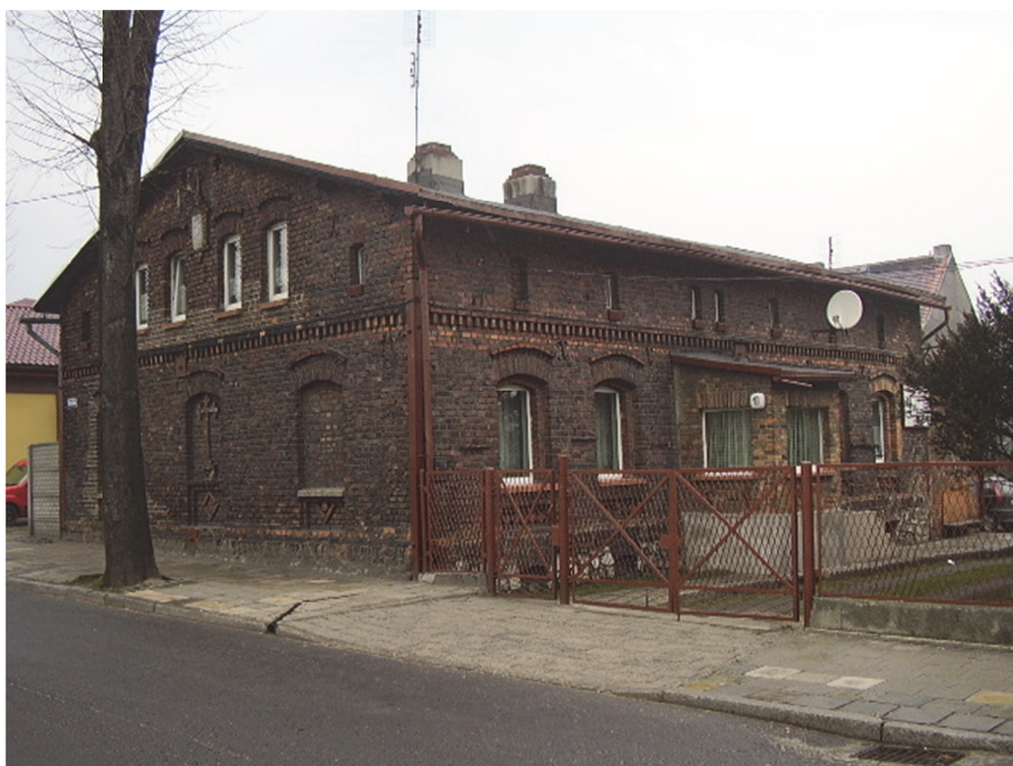
Fot. 6.14. Budynek mieszkalny wybudowany w technologii tradycyjnej
