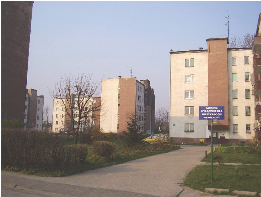
Fot. 6.3. Budynki mieszkalne pięciokondygnacyjne wybudowane w technologii tradycyjnej-ulepszonej
