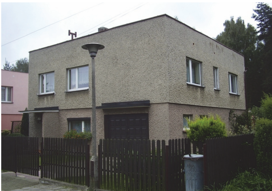
Fot. 6.7. Budynek mieszkalny jednorodzinny wybudowany w technologii tradycyjnej-ulepszonej
