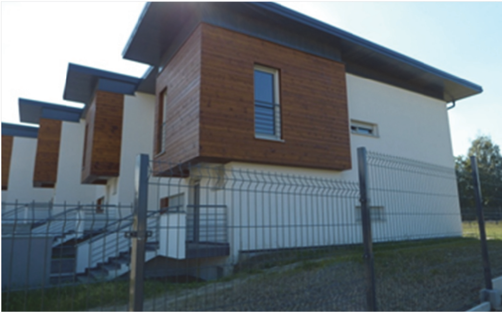
Fot. 6.21. Budynek mieszkalny wybudowany w technologii szkieletowej o konstrukcji żelbetowej
