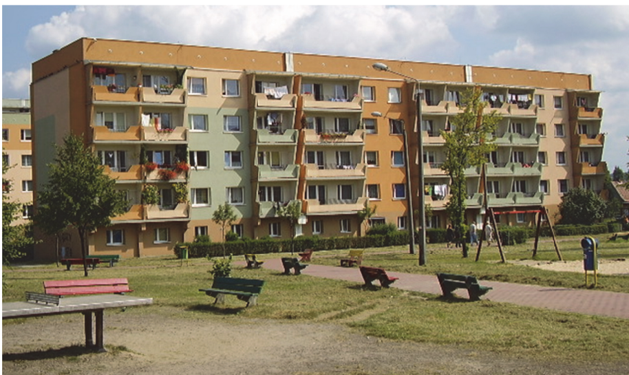
Fot. 6.2. Budynek mieszkalny pięciokondygnacyjny wybudowany w technologii wielkopłytywowej
